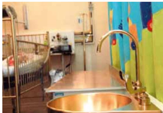
Kuva 3. Huone lastenosastolla: pesuallas, allaspöytä, juoksuputki ja sekottaja, hoitopöydän pinta, tippateline ja sänky päällystetty kuparilla.
