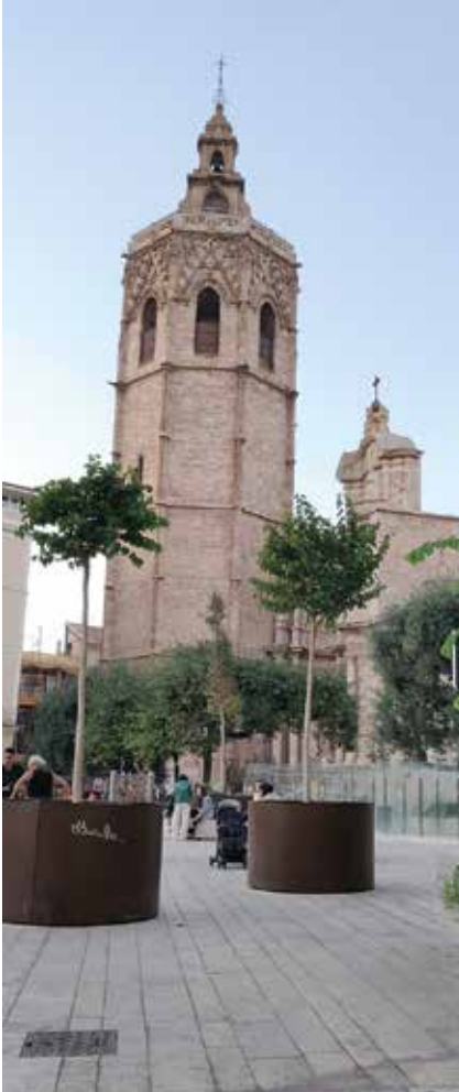
Kuva 6. El Miguelin goottilais-tyylinen kellotorni. Valmistunut 1300- ja 1400-luvun taitteessa.
